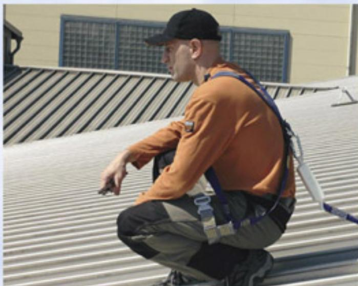
Uz kombinaciju horizontalnog i vertikalnog sistema možete primeniti protiv padnu zaštitu sa maksimalnom slobodom kretanja.
