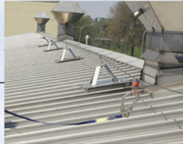
Xenon sistem kačenja je proizveden u Nemačkoj firmi Soll, po najstrožim Nemačkim standardima i ispitivan je u nezavisnoj ustanovi za ispitivanje kvaliteta i normi pri EU. Poseduje sertifikat po Evropskoj normi EN 795.
